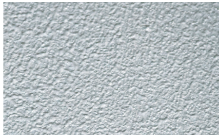
2. Ergebnis des Putzauftrages mit der UniFill-Walze
