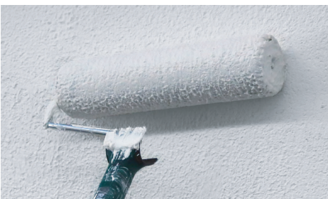
1. Ergebnis des Spachtelauftrages mit der UniFill-Walze
